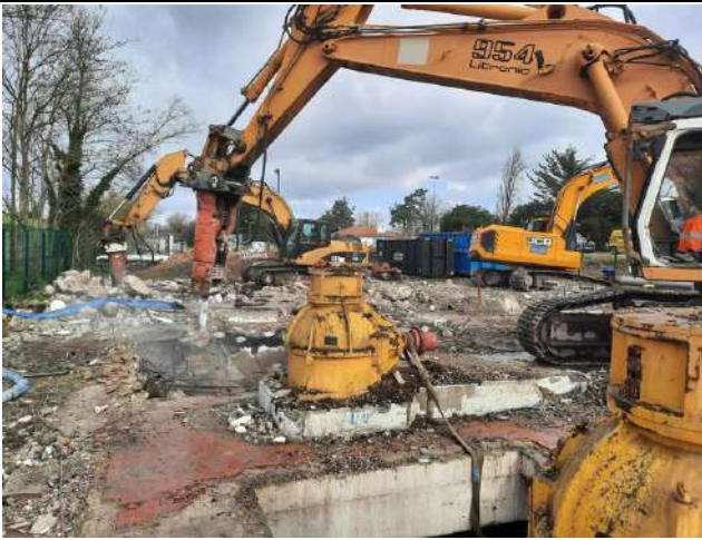
Démolition des voiles et ouvrages hydrauliques
